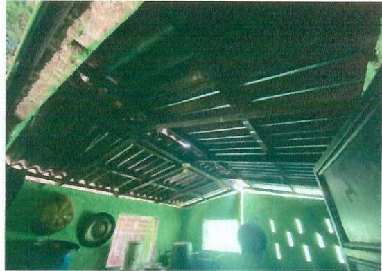
FOTO 2: Cambio de estructura de madera a metal y cubierta de lámina troquelada calibre 26, mejoramiento de puerta en area de cocina
