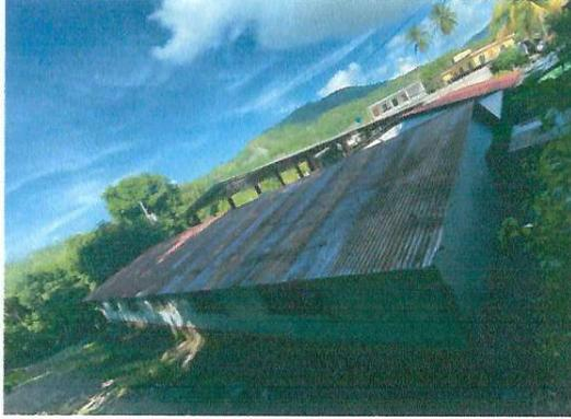
FOTO 1: Instalación de techo con estructura de metal tipo pórtico con cobertura de lámina troquelada calibre 26 a modulo 1, 2,3 y area de dirección.
